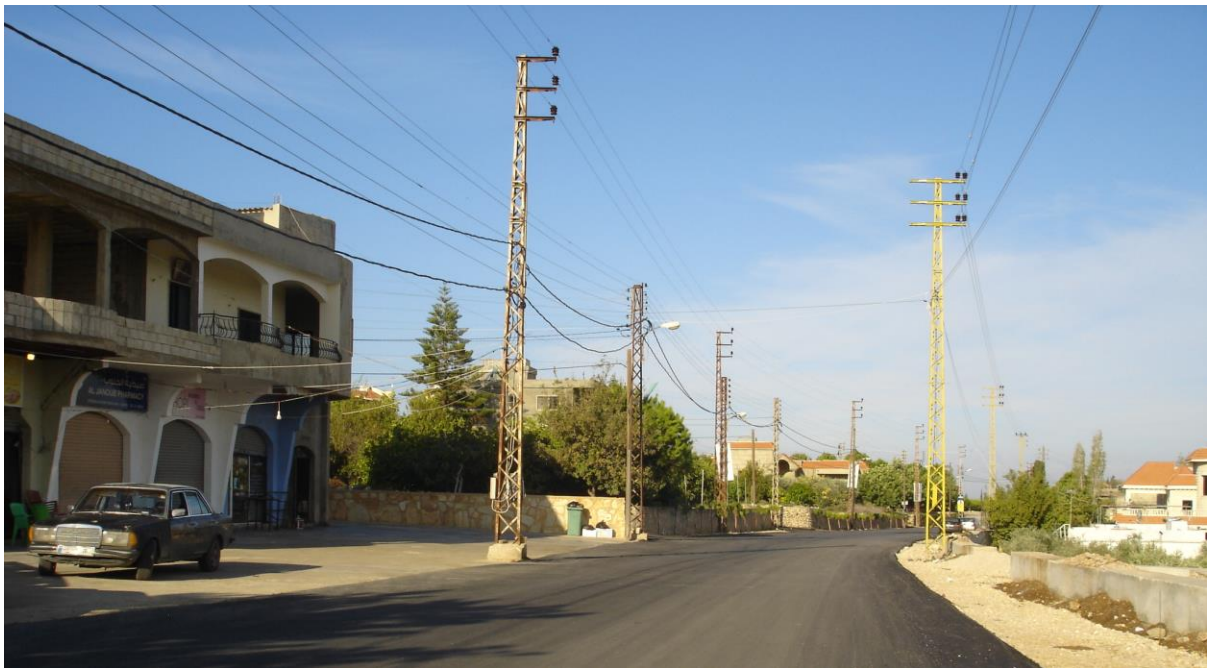
Figure 4-18: Some Shops at Ras El Ein – Qana (L3-SO-RD09)
