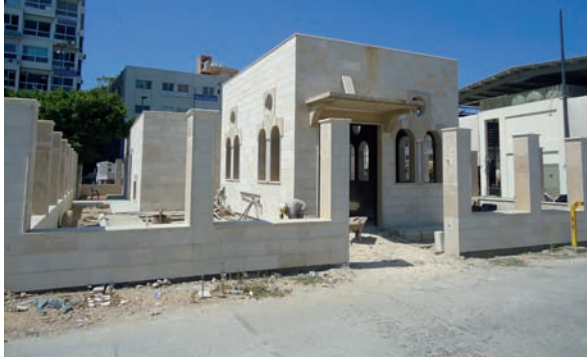
تجهيزات صرف صحي - صور
